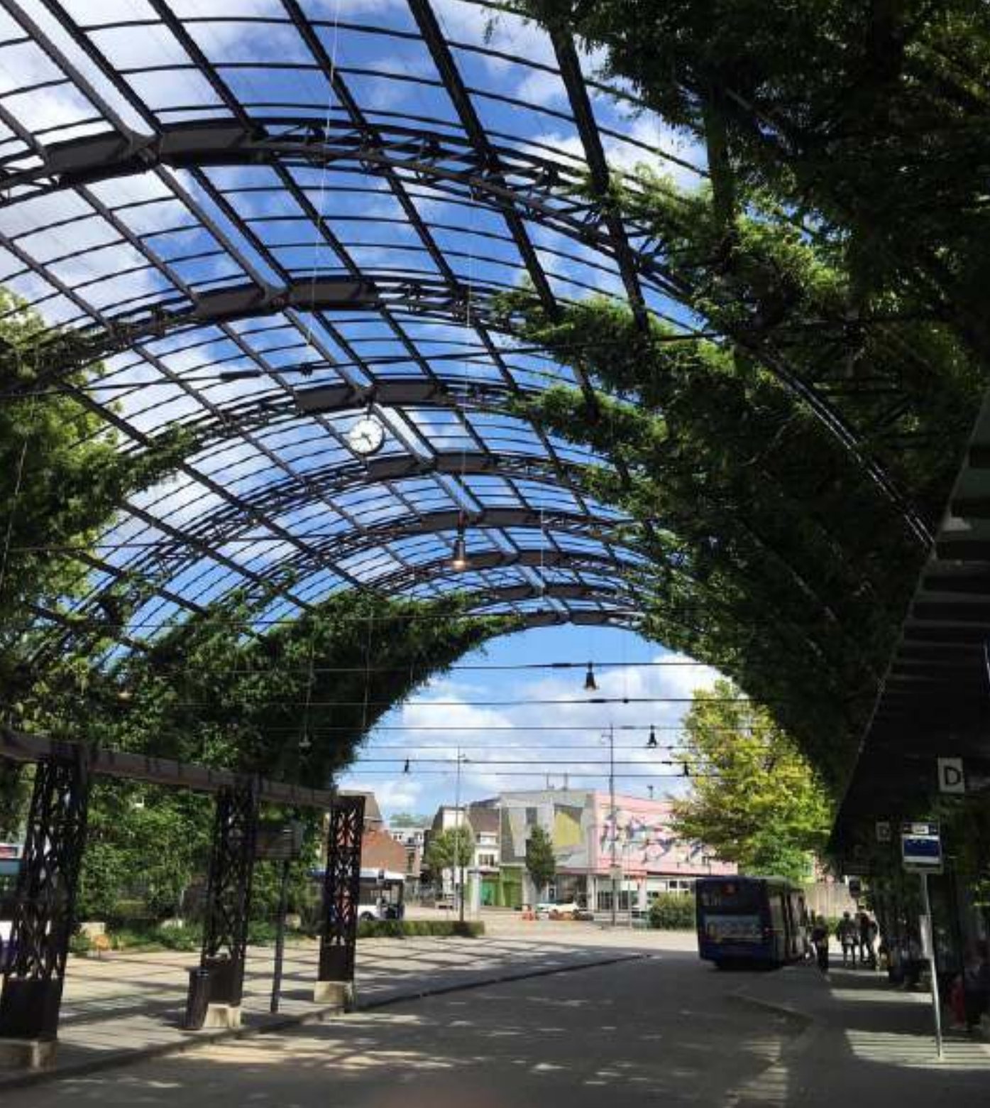
Hittestress- en regenbestrijding bij het busstation in Heerlen
